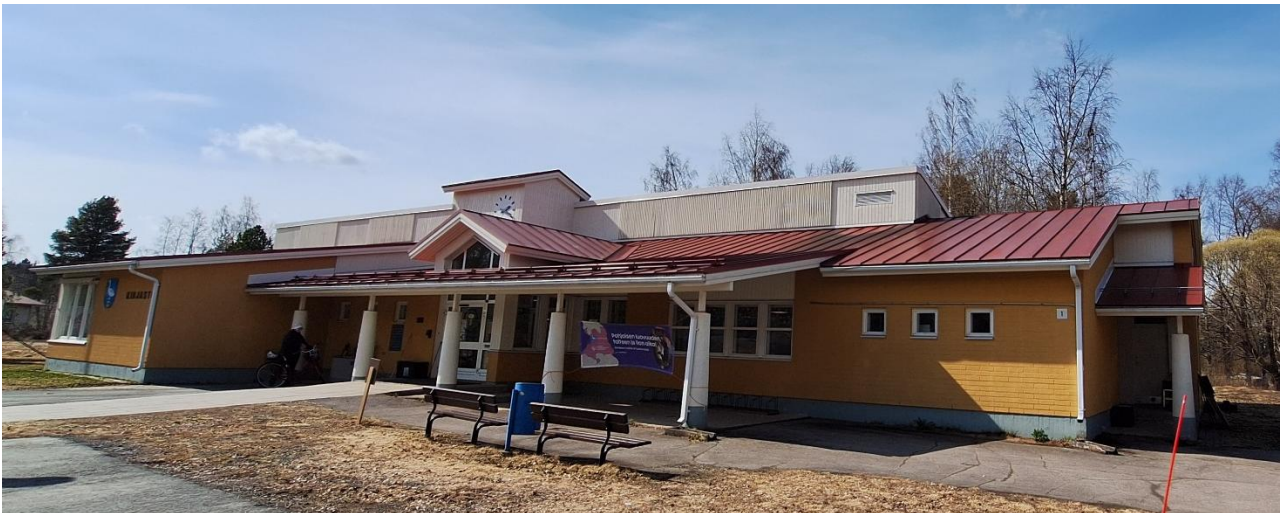
Kuva 29. Yleiskuvaa vesikatolta. Vesikatto on monimuotoinen ja liittymäpintoja tulee paljon.
