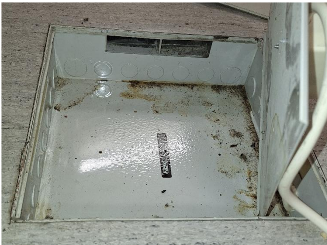
Kuva 8. Lattiaan upotettu sähkökanava. Metallisen kanavan alla lattiavalussa on epäjatkuvuuskohta, josta pääsee virtaamaan kosteaa maan hajua sisäilmaan.
