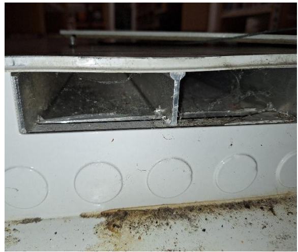
Kuva 8. Lattiaan upotettu sähkökanava. Metallisen kanavan alla lattiavalussa on epäjatkuvuuskohta, josta pääsee virtaamaan kosteaa maan hajua sisäilmaan.
