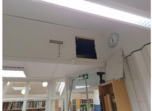
Kuva 25. Kattokotelon rakennetta lehtisalin yläpuolella. Tilassa on runsaasti rakennuspölyä ja kuitulähteitä.
