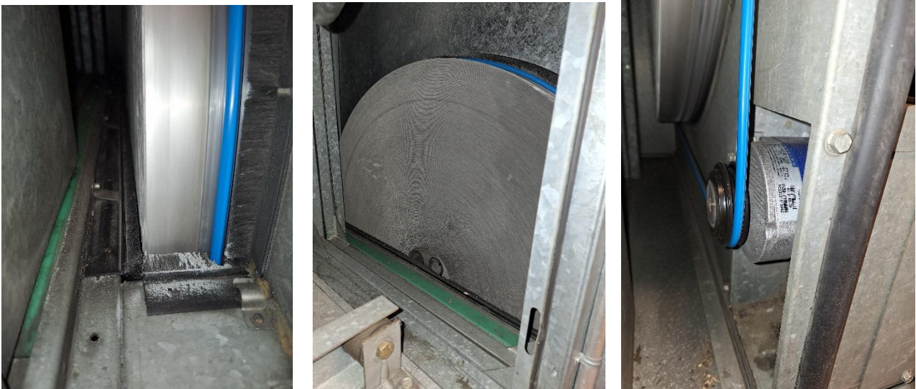
Kuva 39. LTO-kiekon pyörimisessä oli hieman epäkeskeisyyttä. Vasen kuva: pyörimisestä kertyy hienojakoista jauhetta. Keskimmäinen kuva: tiivistysharjakset olivat kunnossa. Oikea kuva: sininen remmi suttaa hieman joka kierroksella.
