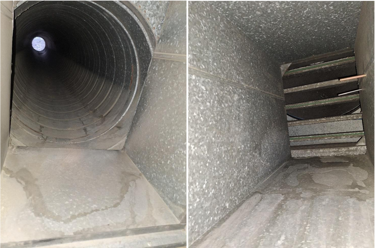
Kuva 43. Raitisilmakanavasta pääsee lunta ja vettä LTO-kennolle saakka.
