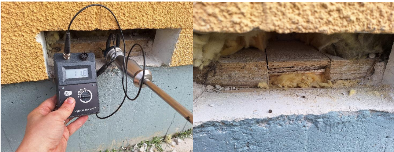
Kuva 16. Rakenneavaus kirjastosalin ulkoseinään.
