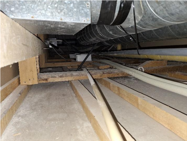
Kuva 25. Kattokotelon rakennetta lehtisalin yläpuolella. Tilassa on runsaasti rakennuspölyä ja kuitulähteitä.
