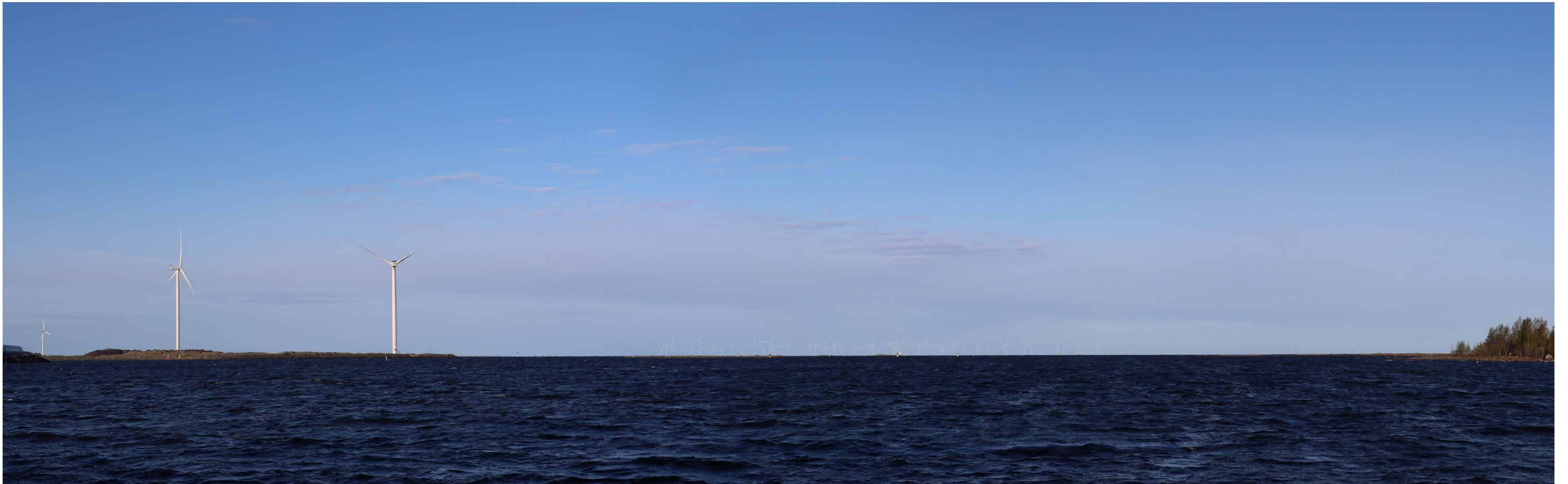
Kuvauspaikka 1. Havainnekuva Raahen ja Pyhäjoen tuulivoimapuistoista. Kuvauspaikka on Raahen Helmi-möljästä (Lapaluodon pohjoispuolelta), joka sijaitsee noin 16 km suunnitellusta tuulivoima-puistosta koilliseen. Edustalla vasemmalla näkyy Kirsholman jo rakennettuja tuulivoimaloita. Pienempänä erottuvat Maanahkiaisen tuulivoimalat. Koostettu panorama, kuvattu 50 mm polttovälillä. Voimaloiden kokonaiskorkeus 350 m.
