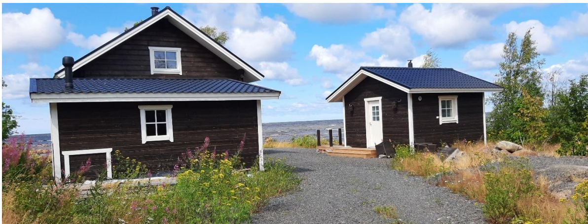
Kuva 28. Olevaa uudempaa rantarakennuskantaa Syölatissä
