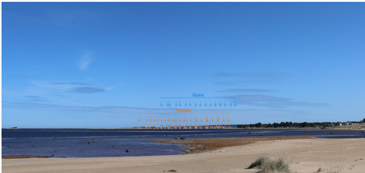
Kuva 11-10. Yhteishavainnekuva ja ns. "rautalankamalli" Pyhäjoen ja Raahen Maanahkaisen tuulivoimapuistoista. Tuulivoimalat on tuotu valokuvan päälle niiden sijainnin havainnollistamiseksi. Kuvauspaikka on Kalajoen Hiekkasärkiltä, joka sijaitsee noin 35 km suunnitellusta tuulivoimapuistosta lounaaseen. Tuulivoimalat erottuvat otollisissa olosuhteissa ja selkeällä säällä hyvin pienikokoisina horisontissa Vihaspauhan ja Letonnokan takana. Kuvassa on esitetty tuulivoimalat kokonaiskorkeudeltaan 350 m (korkeus merenpinnan yläpuolella).
