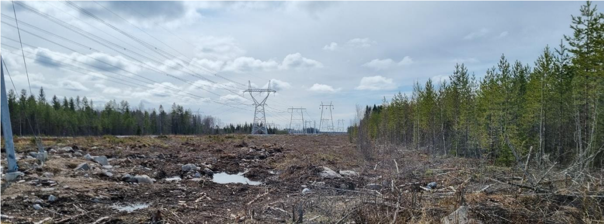
Kuva 23. Voimajohtokäytävä. Kuva sähköaseman koillispuolelta Pöytäpuunnevan tienoilta, missä rinnakkain kulkee paikallisesti kolme voimalinjaa.
