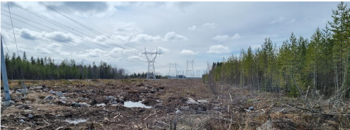
Kuva 31. Voimajohtokäytävä. Kuva sähköaseman koillispuolelta Pöytäpuunnevan tienoilta, missä rinnakkain kulkee paikallisesti kolme voimalinjaa.
