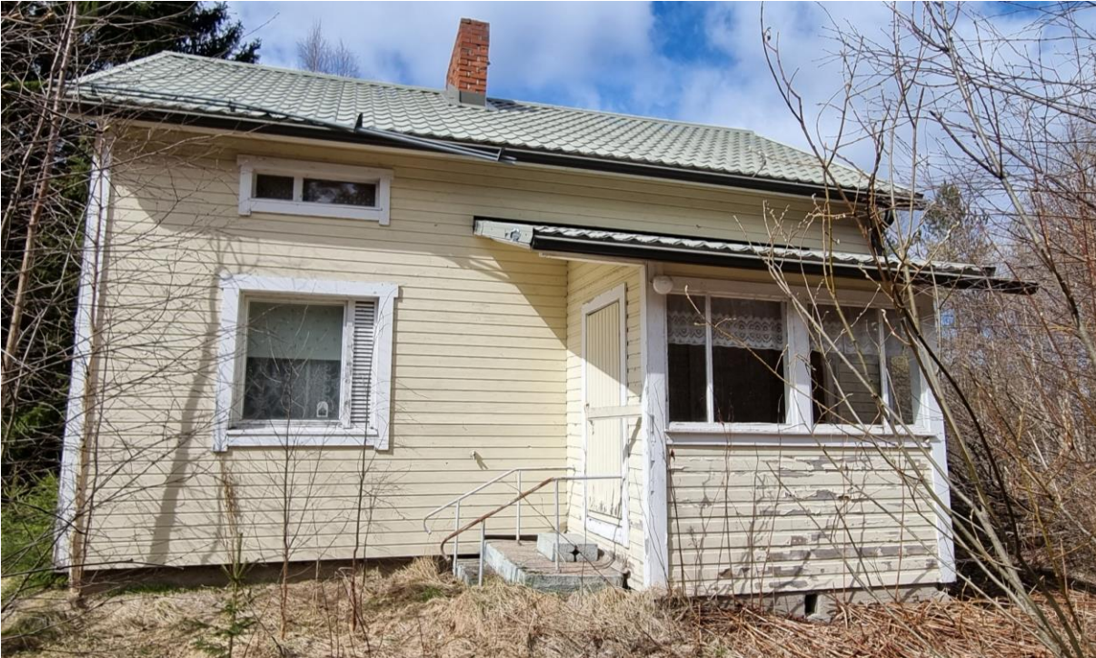
Kuva 43. Asuinrakennus on rakennettu jälleenrakennuskaudella 1950-luvun tienoilla. Rakennusta on myöhemmin uudistettu, ikkunat ja kate on uusittu.
