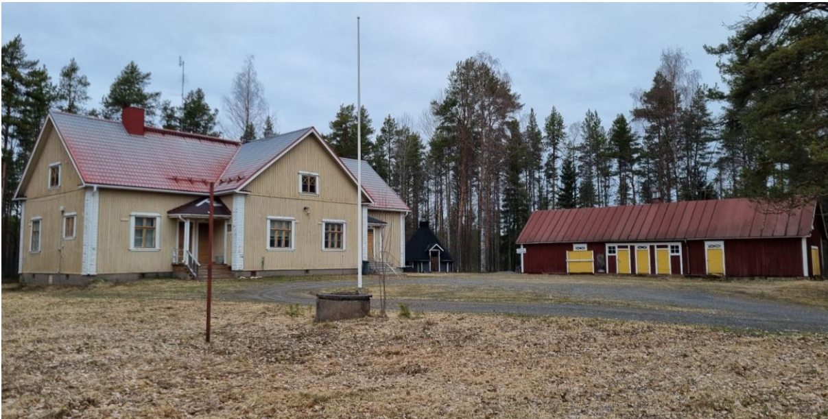
Kuva 51. Keskikylän vanha koulu, nykyinen kylätalo. Kookkaan koulurakennuksen vieressä ovat alkuperäinen ulkokuone/varastorakennus ja uudehko grillikota.
