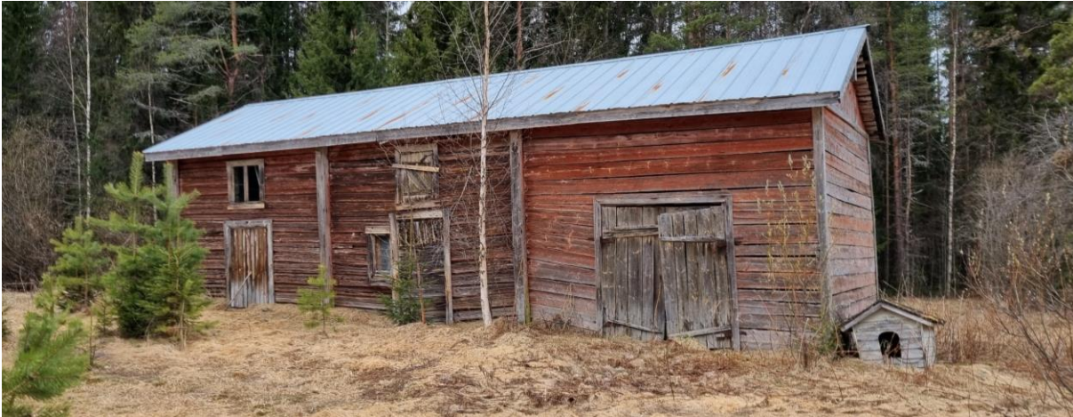
Kuva 36. Kolmiosainen, hirsirakenteinen puoji sijaitsee asuinrakennusta vastapäätä pihapiirin länsilaidalla.
