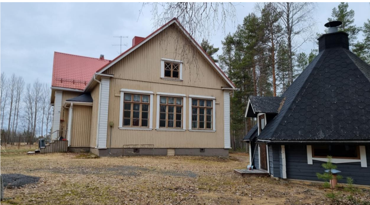
Kuva 53. Koulurakennuksen pääty pohjoisen suuntaan ja grillikota. Koulurakennuksen päädyssä erottuvat luokkahuoneen suuret ikkunat.
