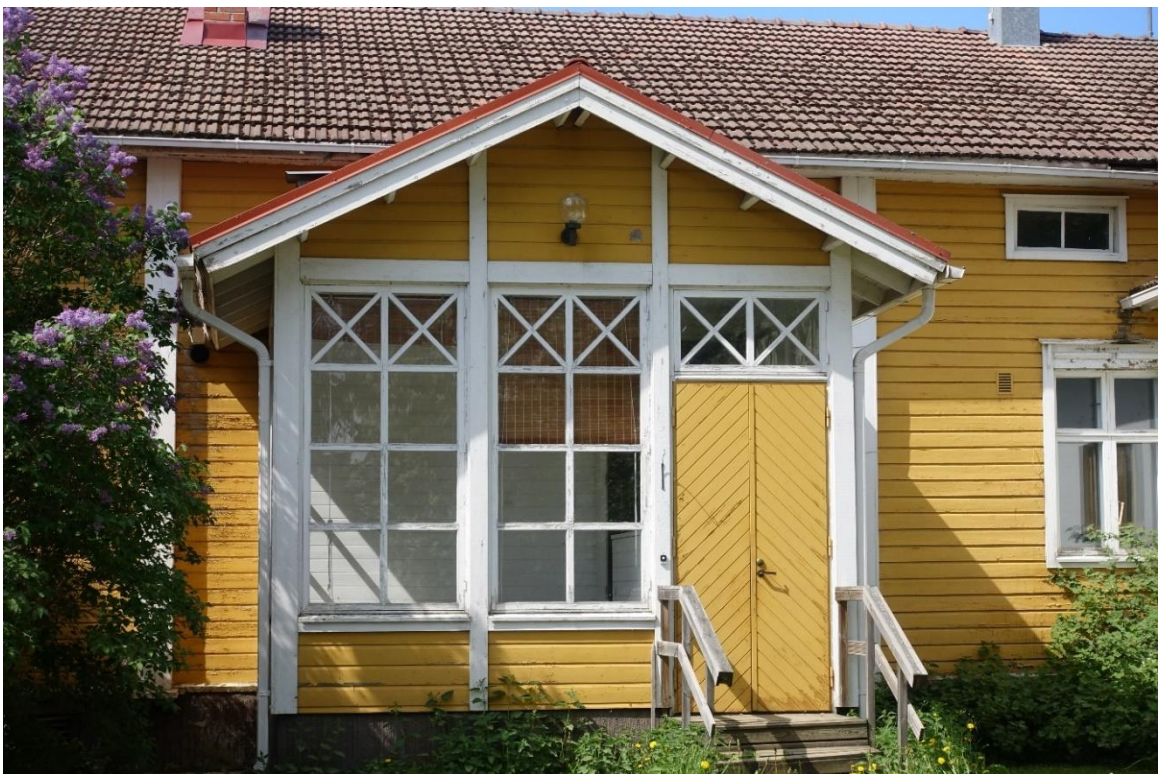
Kuva 35. Kuisti on rakennettu vuonna 1979.
