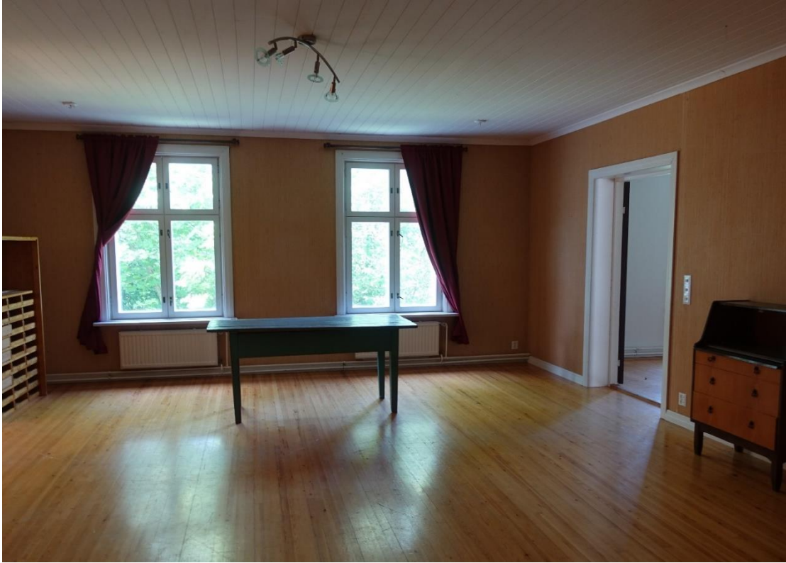
Kuva 39. Remontissa huoneisiin laitettiin kapeat lautalattiat, ponttilautakatot ja seinät levytettiin. Arkihuoneen ja keittiön väliin asennettiin liukuovi.
