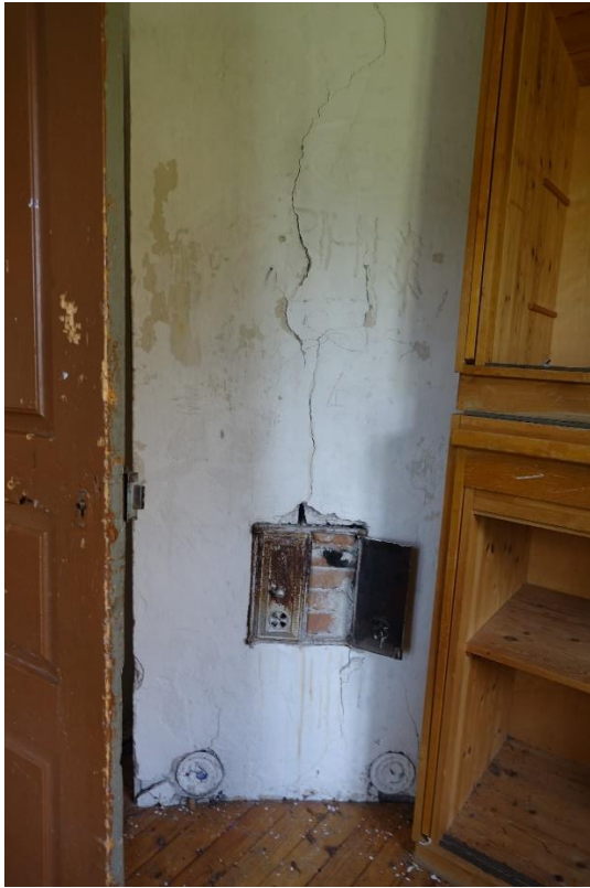
Kuva 50. Umpeen muurattu uuni toisessa kamarissa.
