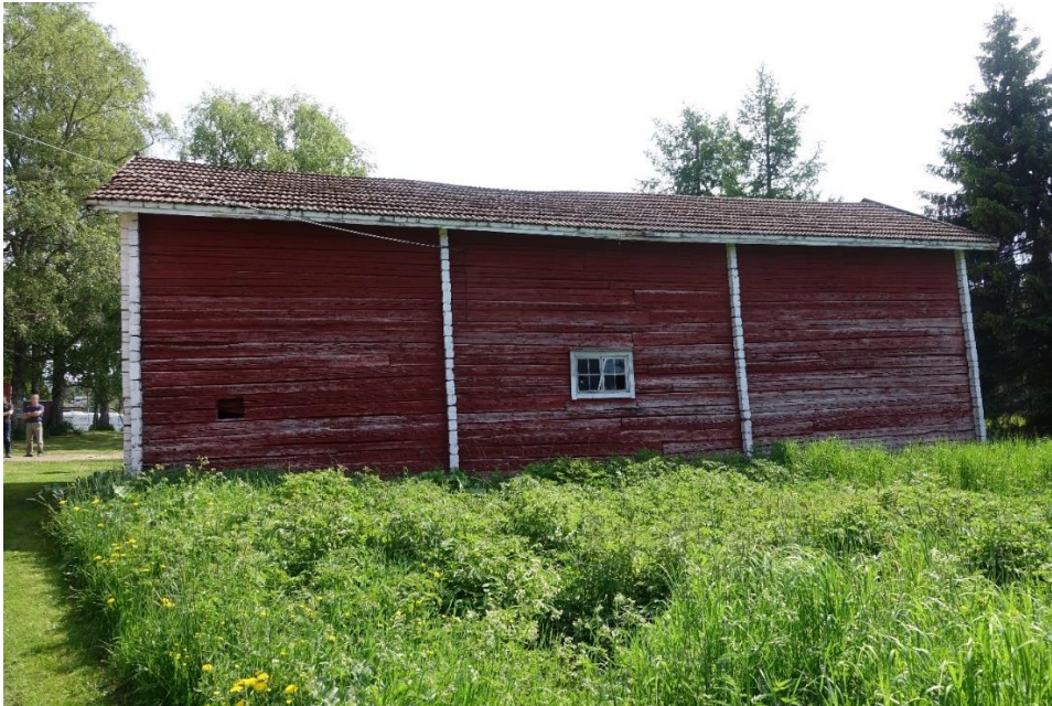
Kuva 54. Puojin takaseinällä on pieni ikkuna.
