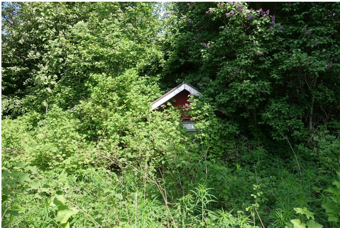
Kuva 75. Kellari on jäänyt käyttämättömänä kasvillisuuden peittoon.
