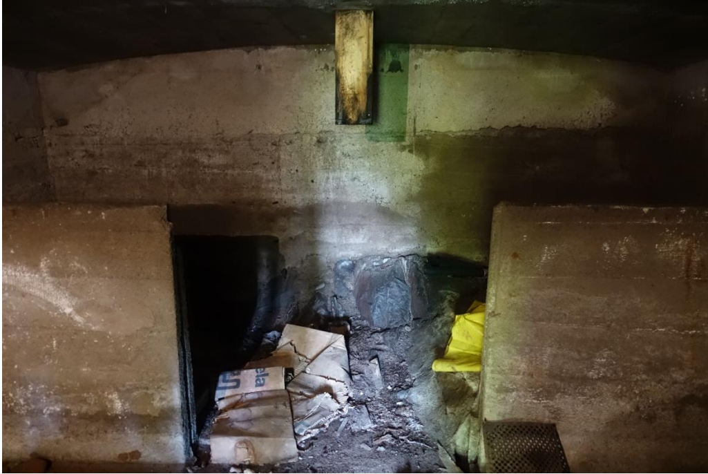
Kuva 76. Kellari on sisäpuolelta betonoitu.
