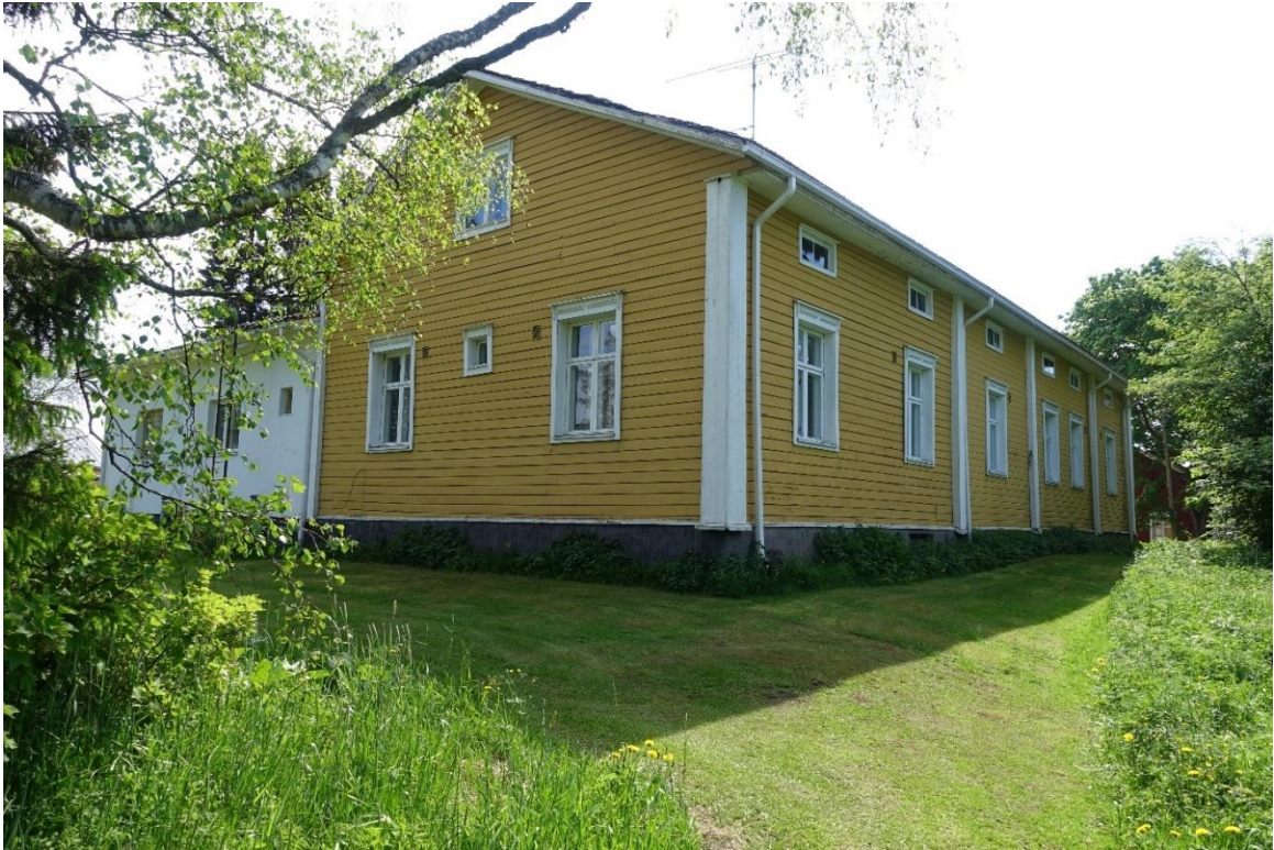
Kuva 34. Pohjoispääty ja julkisivu etelään. Ikkunat ovat syvennyksessä, joten rakennus on luultavasti eristetty ja laudoitettu myös ulkopuolelta.
