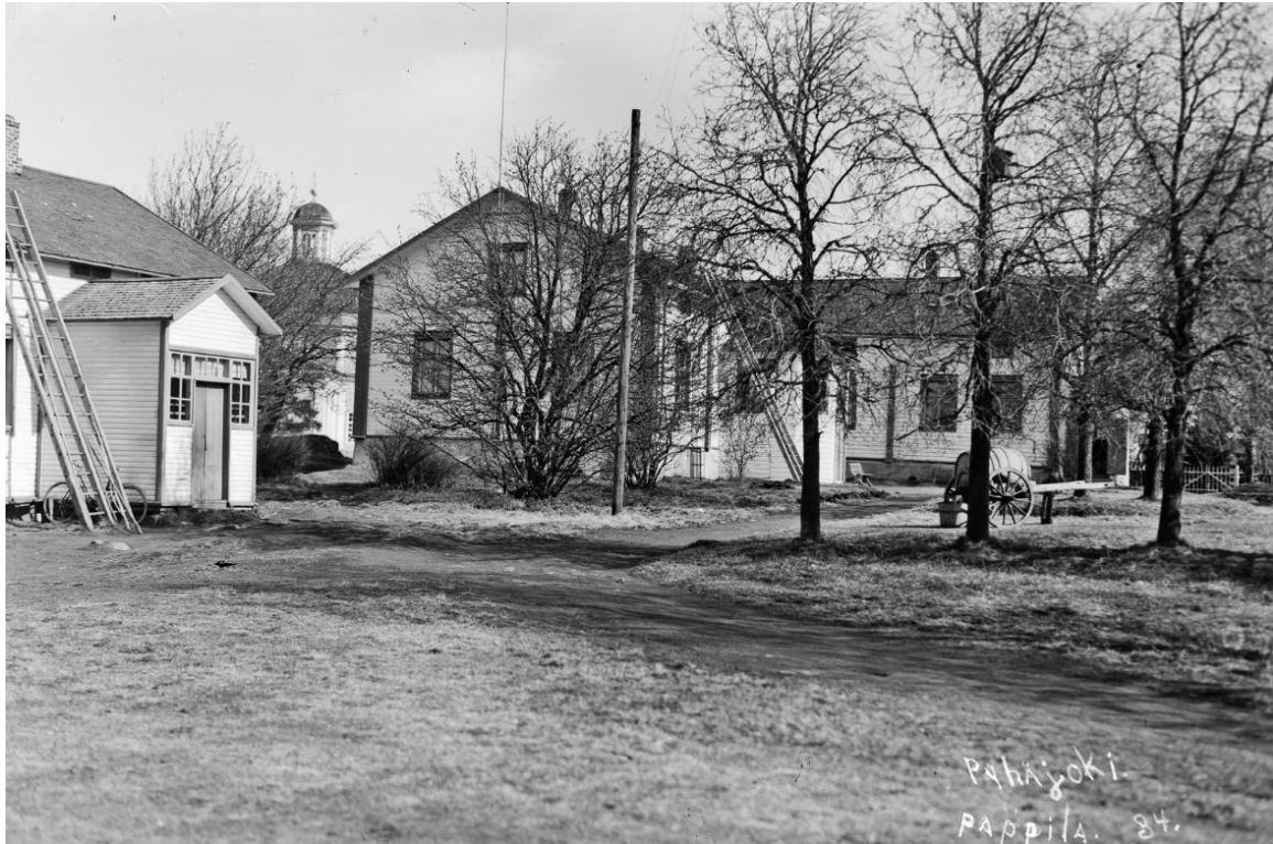
Kuva 27. Pyhäjoen pappila vuonna 1934. Kuvassa näkyvät sittemmin purettu hirsivinkkeli ja mutterikuisti. Kuva Erkki Tuuttila. Pyhäjoen kotiseutuarkisto ja Eila Kultalan arkisto.
