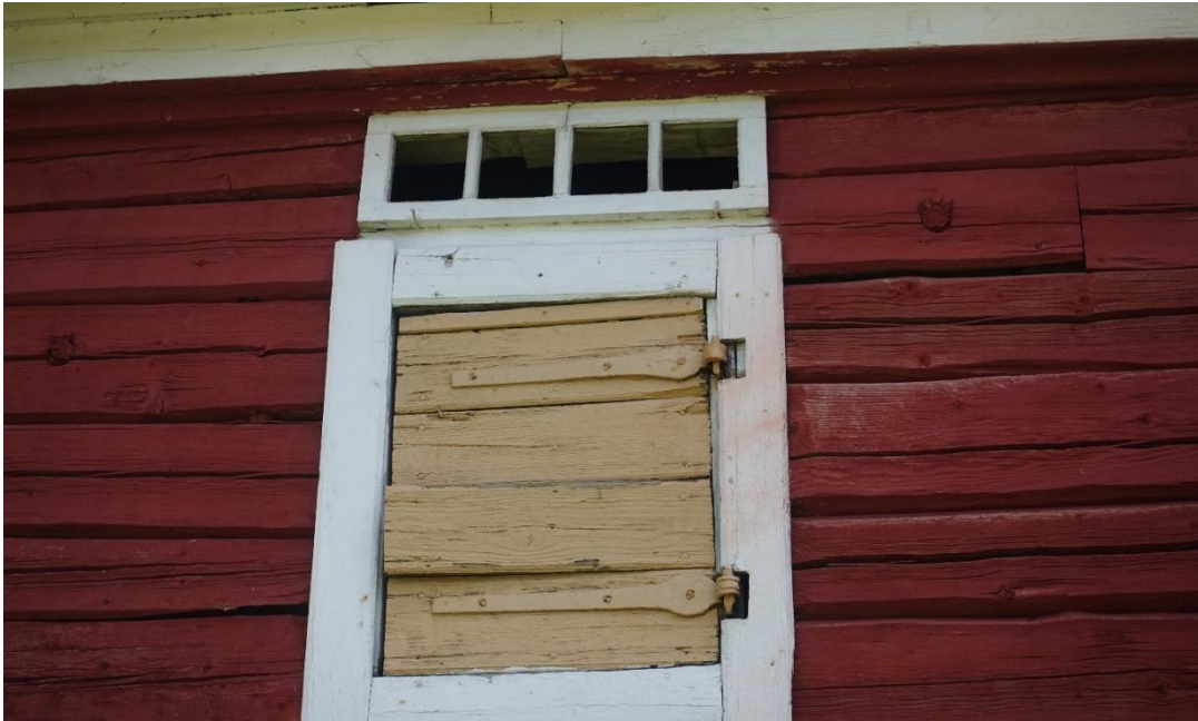
Kuva 66. Aitan vintille johtaa luukku, jonka yläpuolella on pieni ikkuna.
