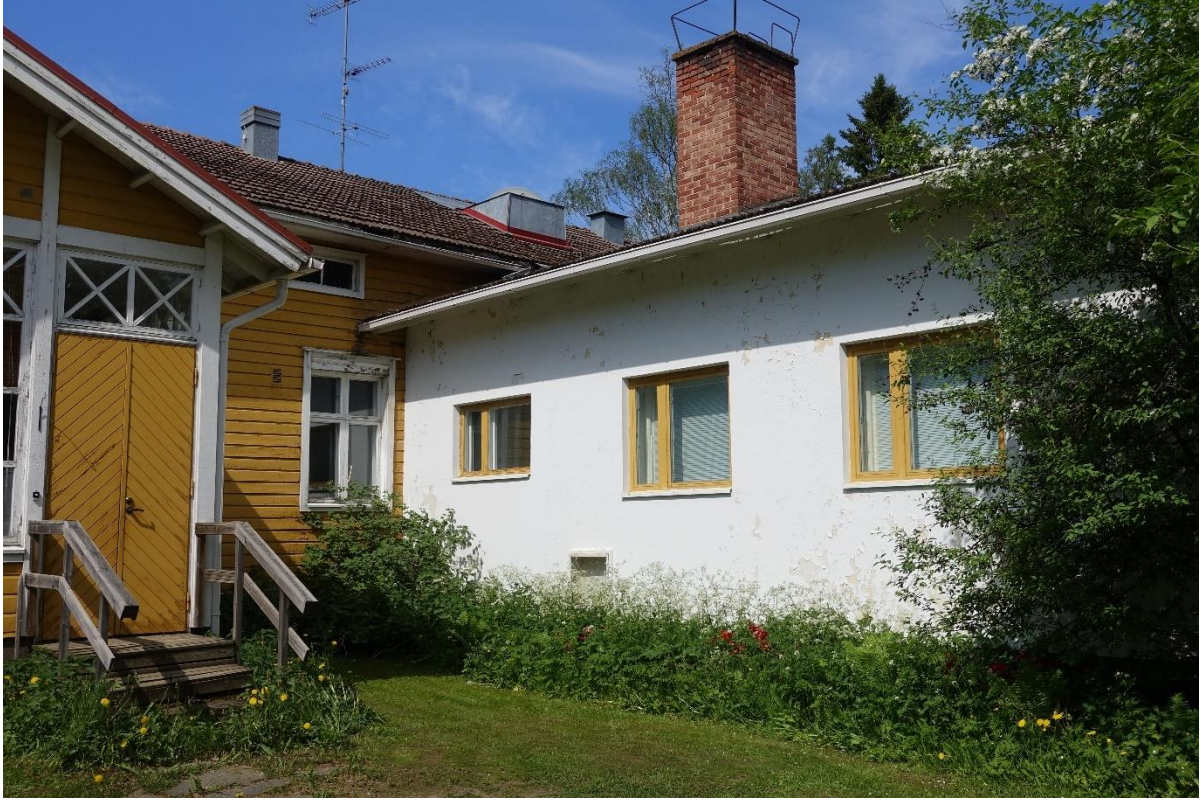
Kuva 36. Laajennusosan ja vanha osan nurkassa oli alun perin sisäänkäynti, joka on kuitenkin poistettu myöhemmin.
