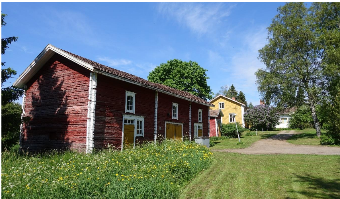
Kuva 1. Pappilan pihapiiriä. Etualalla puoji/talli, pappilarakennus näkyy taustalla.
