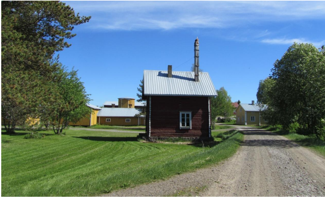
Kuva 17. Paikallisesti arvokasta rakennettua 1800-luvun kulttuuriympäristöä kuvattuna Helaakoskelta.
