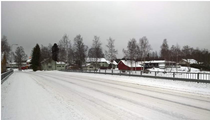
Kuva 6. Pohjankylänsilta (Kuva Ramboll Finland Oy).
