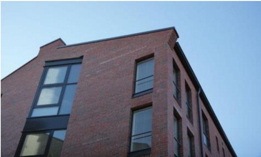
Kuvassa esimerkki tavoiteltavasta materiaalinkäytöstä, jossa vaihteleva vanhaan tiilenpolttotyyliin sopiva punatiili on yhdistetty mustan metallipinnan kanssa.
