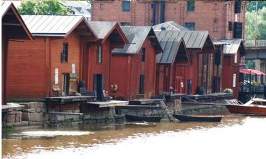
Kuva 10. Kielosaaren alueen esitetty rakentamistapa pohjautuu perinteiseen vesistön äärellä olevaan aittariviin. Ylinnä Oulun torinrannan aitat, jotka kunnostettiin 1990-luvun lopulla ja niistä tuli etenkin matkailijoiden suosima kohde. Keskellä kalastukseen liittyvä aittarivi Himangan Sautinkarista ja alinna ehkä Suomen kuuluisimmat aitat Porvoosta.
