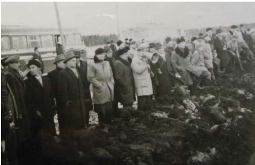
Kuva 16. Presidentti Urho Kekkonen seuraamassa Liminkakylän ojitustyömaata. PKoA.
