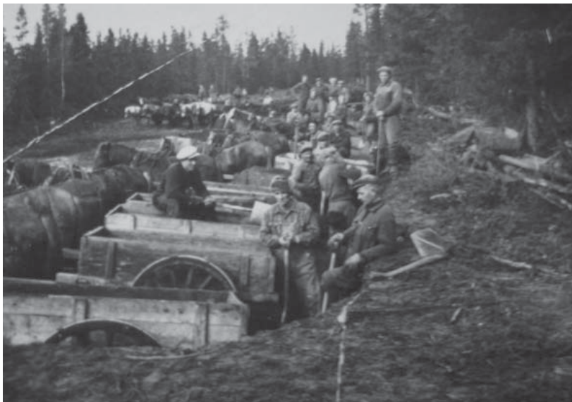
Kuva 28. Soranojoo rantamaantien kunnostamiseen 1920-luvulla. PKoA.
