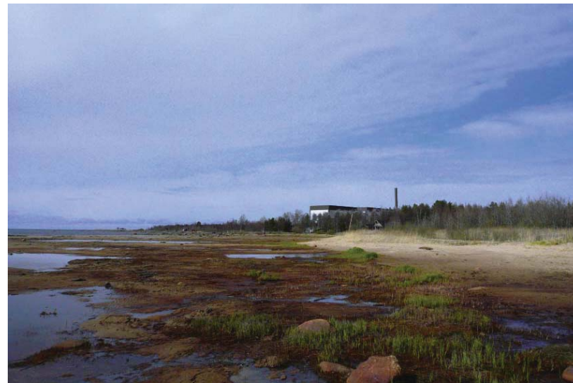
Kuva 198. Hanhikiven ydinvoimala mereltä päin katsottuna. Fennovoima 2008.
