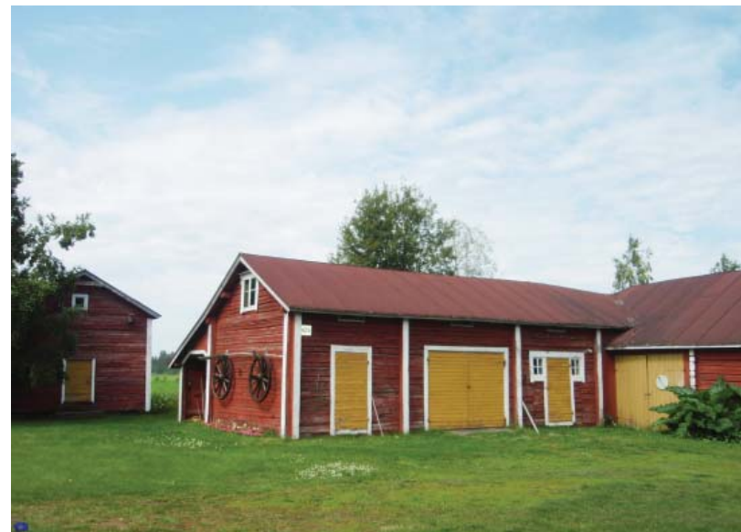
Kuva 89. Kokkolantie 429:n piharakennuksia. Sanna Heikkinen 2008.
