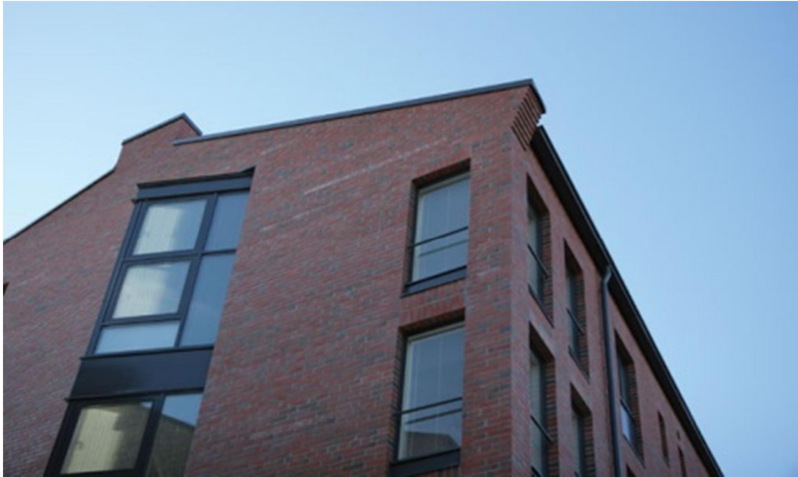
Kuva 4. Kuvassa esimerkki korttelin 455 ja 456/2 tavoiteltavasta materiaalinkäytöstä, jossa vaihteleva vanhaan tiilenpolttotyyliin sopiva punatiili on yhdistetty mustan metallipinnan kanssa.
