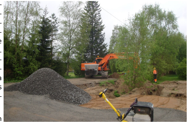
Koulun rakennustyöt käynnistyivät keskiviikkona 4.6.2014
