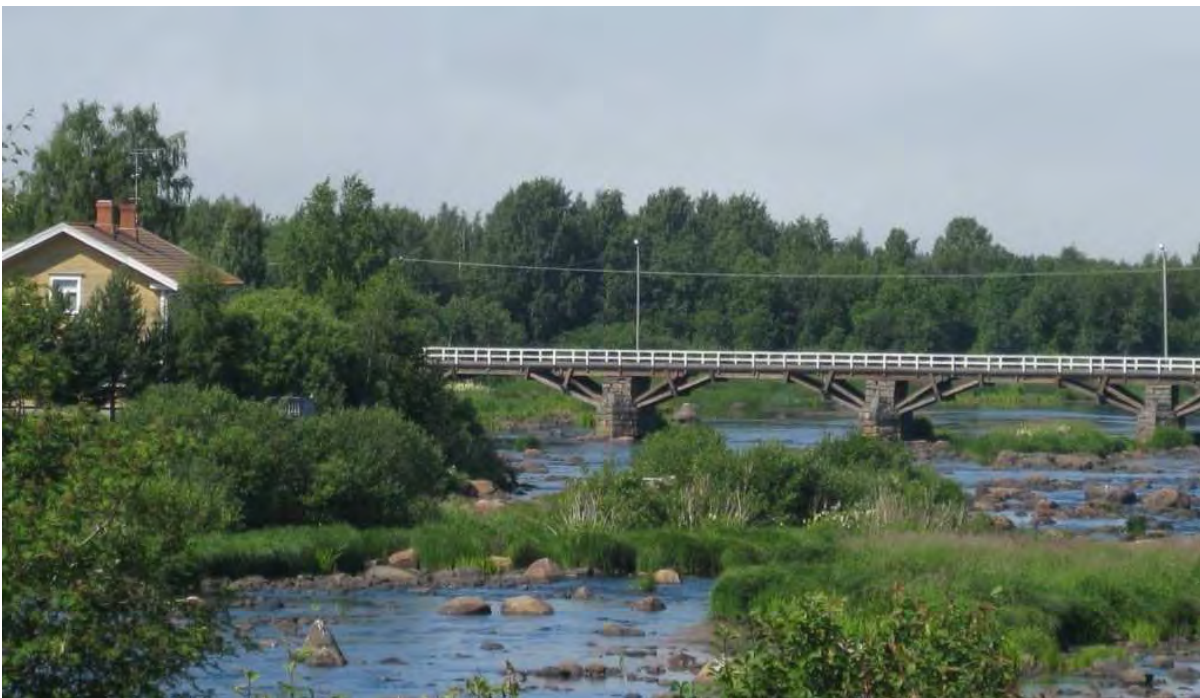
Pyhäjoen Etelähaaran ylittää kulttuurihistoriallisesti arvokas Isosilta.
